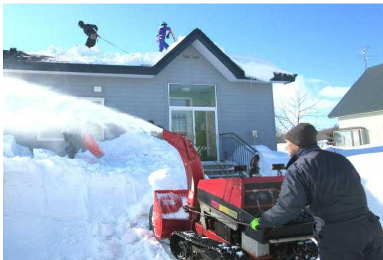
見事に連携の取れた除雪作業。初心を忘れず安全作業！
